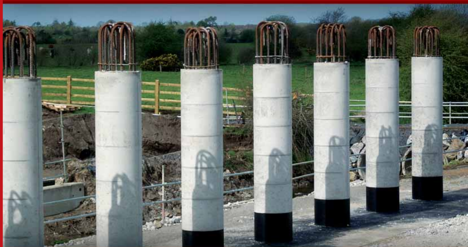
первая пластиковая опалубка для круглых колонн
