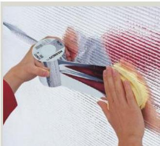
Прочная клейкая односторонняя лента с алюминиевым напылением. Только для плёнки DELTA®-REFLEX/DELTA®-REFLEX PLUS.
