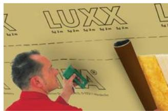
Пароизоляционная плёнка с ограниченной диффузией пара.
