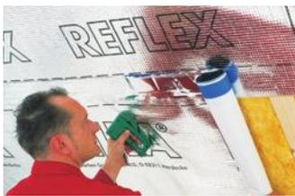
Пароизоляционная плёнка для скатных и плоских крыш.
