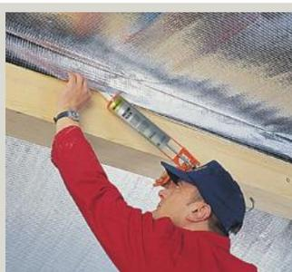
Клей для герметичного воздухо- непроницаемого соединения любой пароизоляции с каменной или кирпичной кладкой, металлическими и деревянными элементами крыши.
