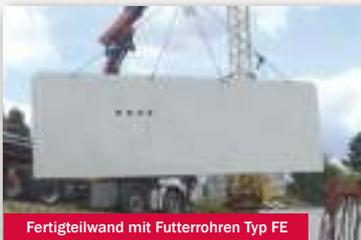
Fertigteilwand mit Futterrohren Typ FE
