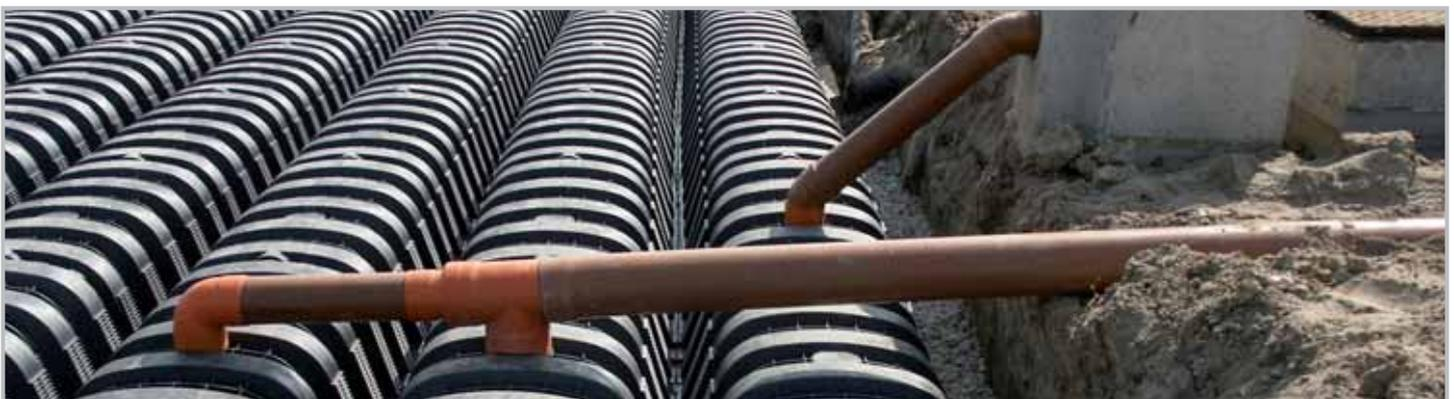
рисунок 9) Пример подсоединения труб в верхней части системы **DRENING®**.
