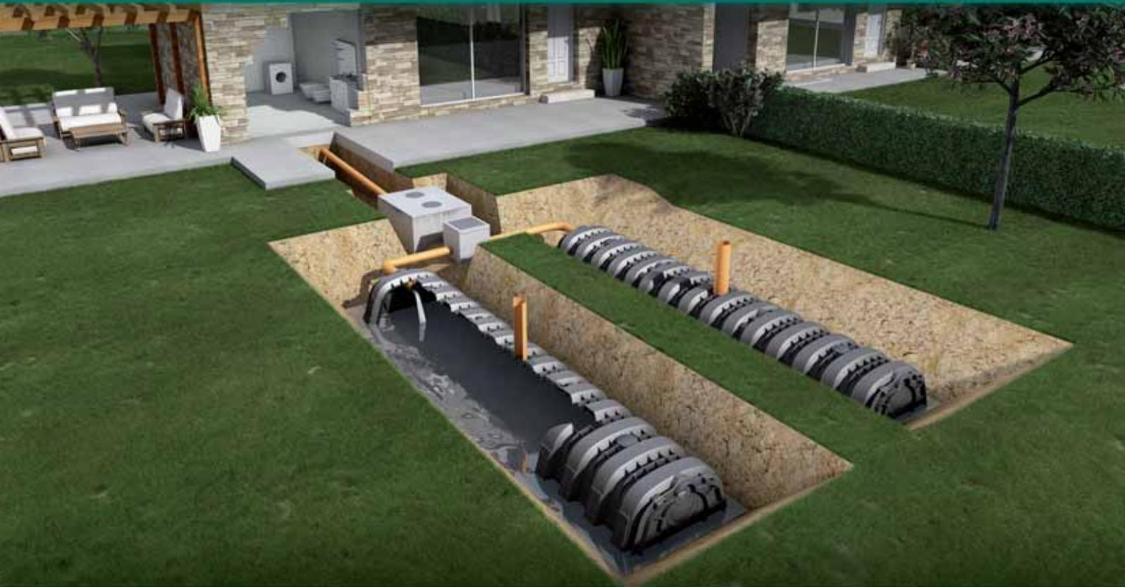
Система обработки сточных вод
