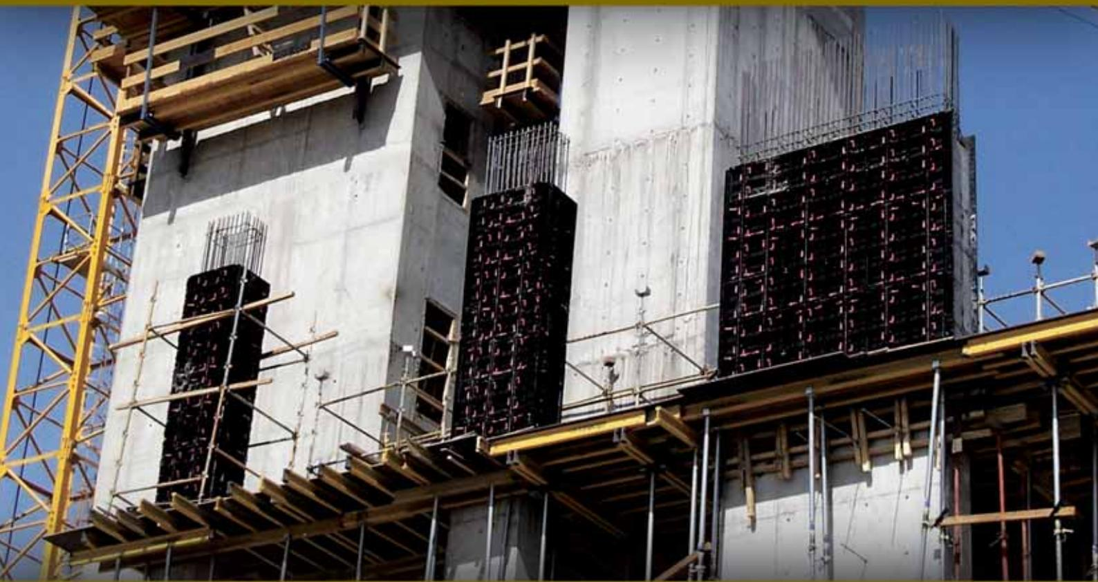
система модульной пластиковой опалубки
