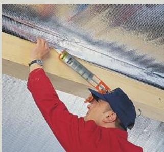
Клей для герметичного воздухонепроницаемого соединения любой пароизоляции с каменной или кирпичной кладкой, металлическими и деревянными элементами крыши.
